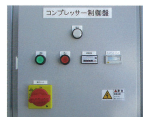
制御盤操作部 (オプション: 吐出温度警報ランプ)
